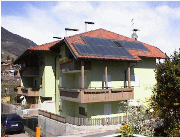
Residence – 25,2 m 2 di pannelli
